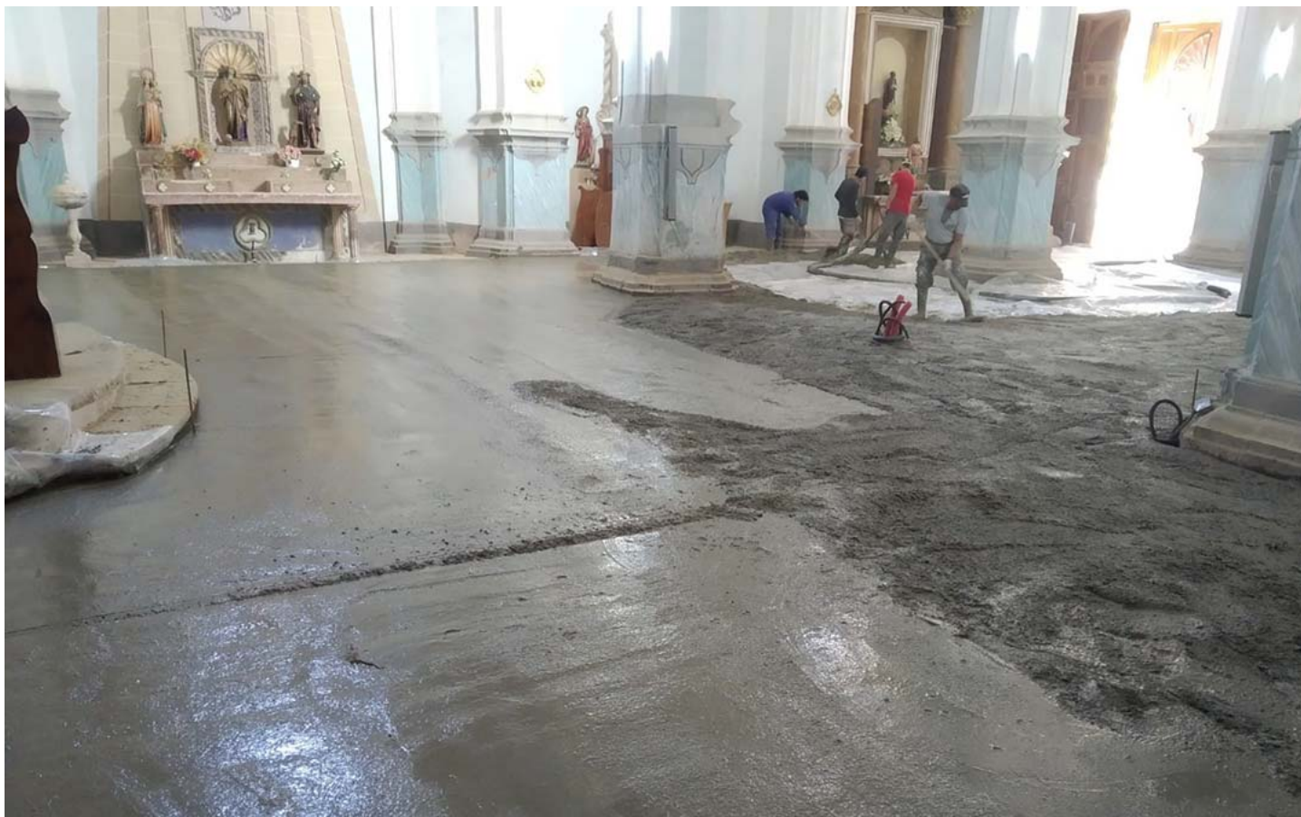
Obras de rehabilitación en la iglesia de Allepuz./I. Martínez
